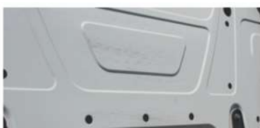
✓ Tylna ściana kabiny kierowcy - ślady użytkowania
