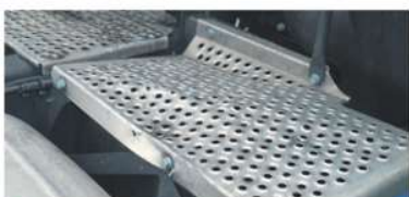
✗ Osłona ramy – znaczące uszkodzenia wykraczające poza normalne ślady zużycia • Znaczące odkształcenia
