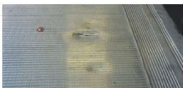
✗ Winda załadownicza - znaczące uszkodzenia wykraczające poza normalne ślady zużycia • Odształcenia i pęknięcia materiału
